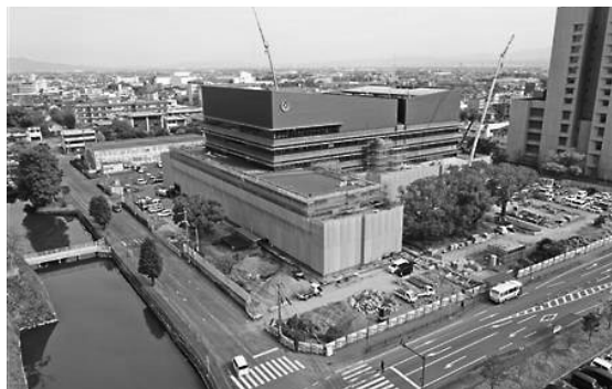
新庁舎空撮工事現場南西側 R3.10.30撮影 (八代市公式ホームページより引用)
